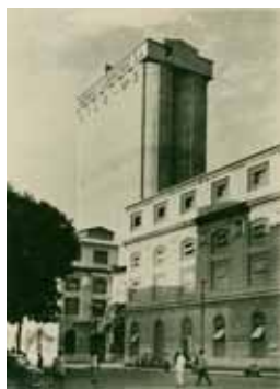
Silo nº 3, visto da Rua Antonio Lajes, s/d, Rio de Janeiro (RJ), autoria não identificada. Acervo Centro de Memória Bunge. Concluído em 1955, o silo representou, em sua especialidade, verdadeiro monumento da engenharia.
